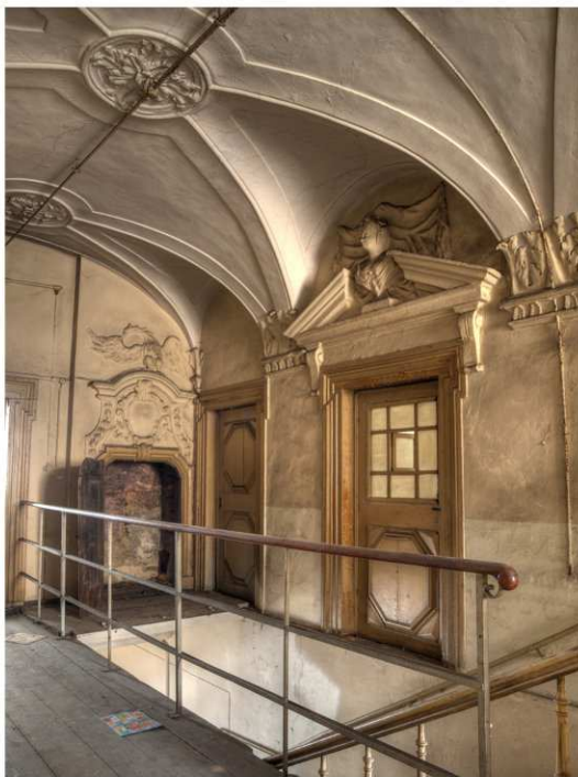
Flur im Obergeschoss (Foto: A. Jordan)
