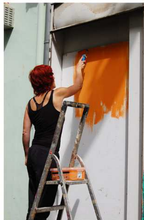
Arbeiten an der Fassade (Foto: S. Thamm)
